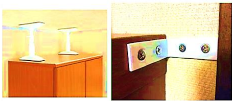
家具の転倒防止対策
