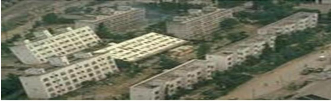
(液状化による倒壊・傾き被害・道路被害写真)
